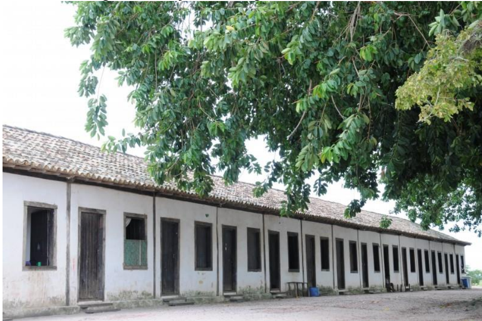
Figura 5 – Conjunto de antigas senzalas reformadas
